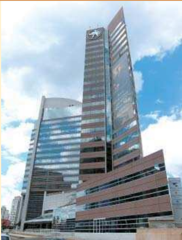
Linha de refletivo da Cebrace reveste fachada do Ceasar Park em Guarulhos, São Paulo
